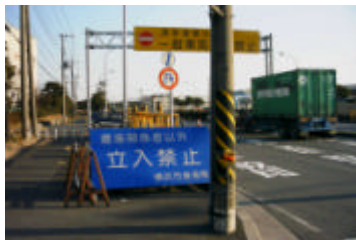
立入 進入禁止ゲートの設置 夜間のみ封鎖)
