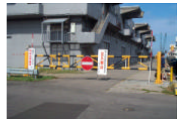
パース内への立入、進入 禁止ゲートの設置（常時）
